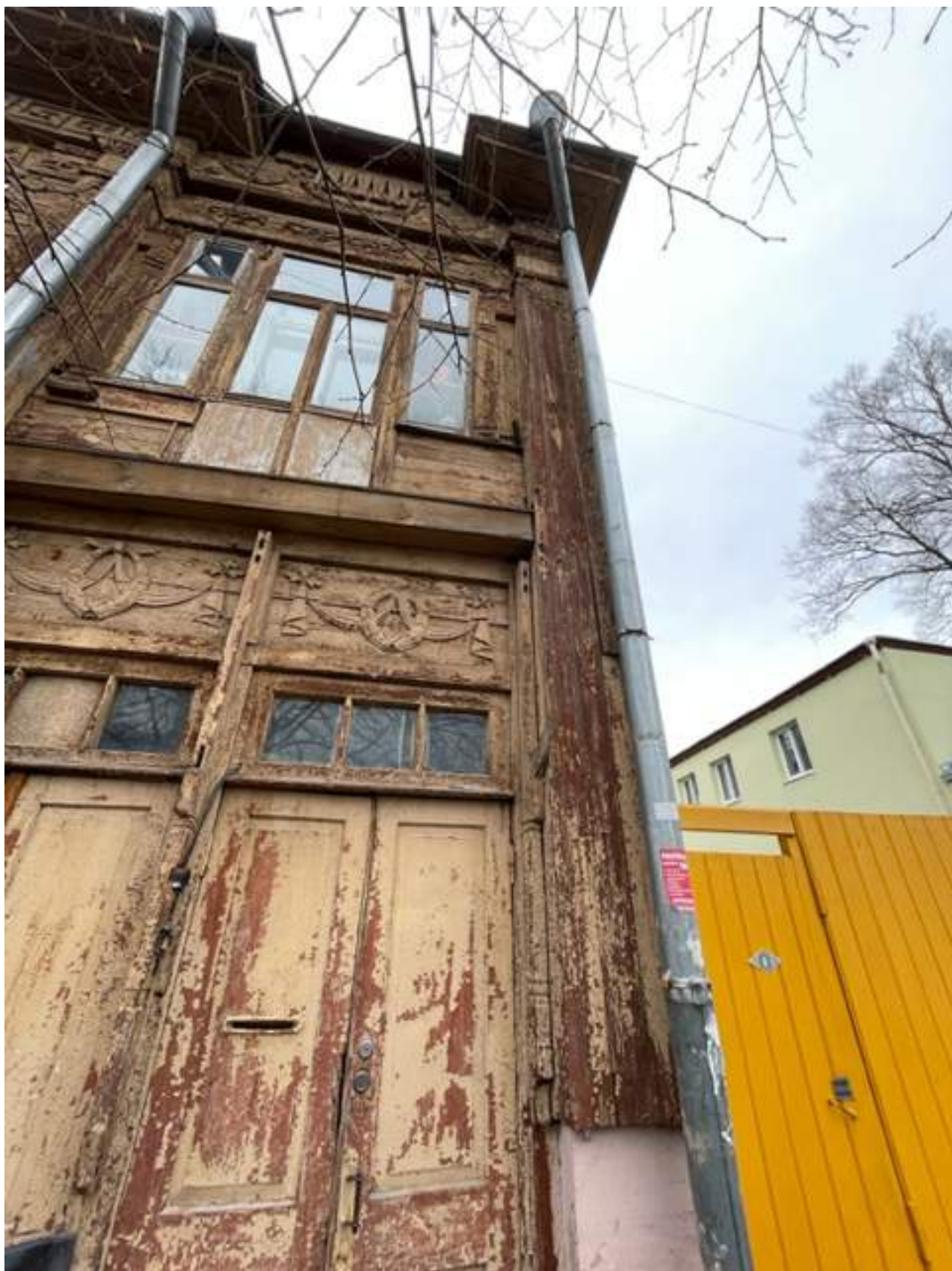
Фото 6. Фрагмент южного фасада. Эксперт Беляева Е. Э. 14.11.2023 г.
