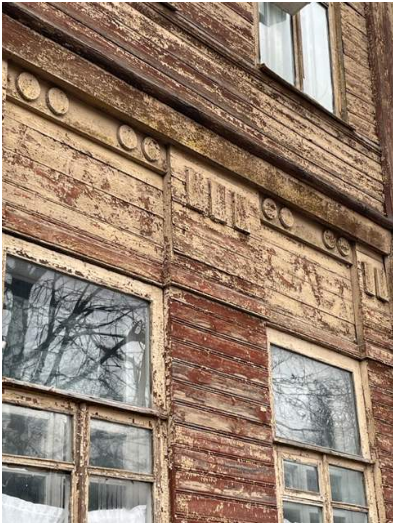
Фото 8. Фрагмент южного фасада. Эксперт Беляева Е. Э. 14.11.2023 г.
