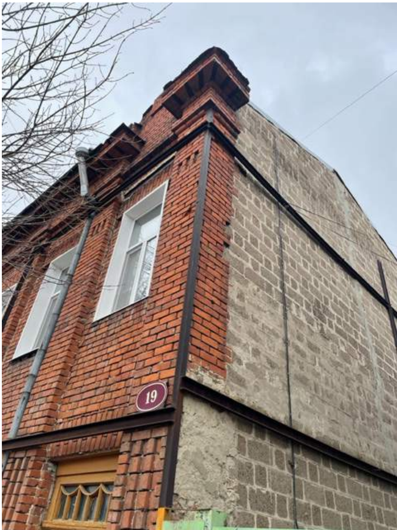
Фото 2. Фрагмент южного и восточного фасадов. Эксперт Беляева Е. Э. 14.11.2023 г.
