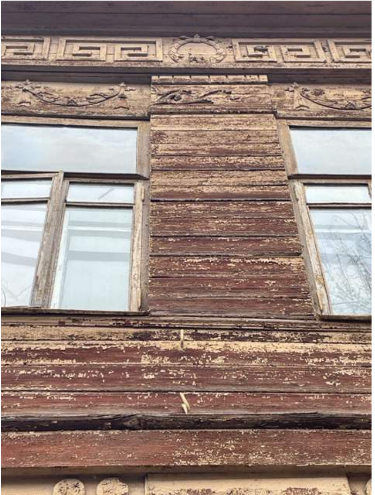
Фото 9. Фрагмент южного фасада. Эксперт Беляева Е. Э. 14.11.2023 г.
