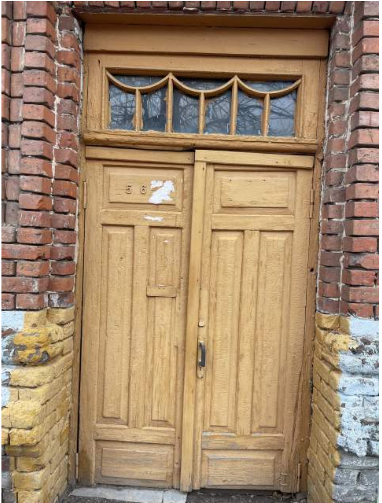
Фото 11. Фрагмент южного (главного) фасада. Эксперт Беляева Е. Э. 14.11.2023 г.
