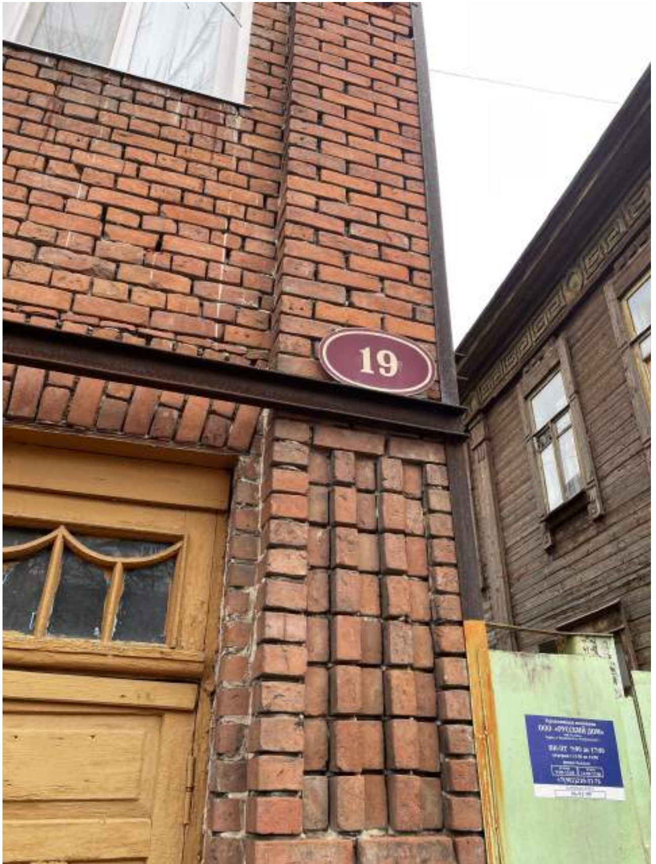
Фото 12. Фрагмент южного (главного) фасада. Эксперт Беляева Е. Э. 14.11.2023 г.
