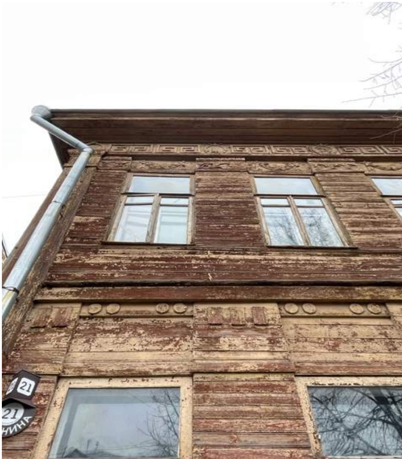
Фото 7. Фрагмент южного фасада. Эксперт Беляева Е. Э. 14.11.2023 г.
