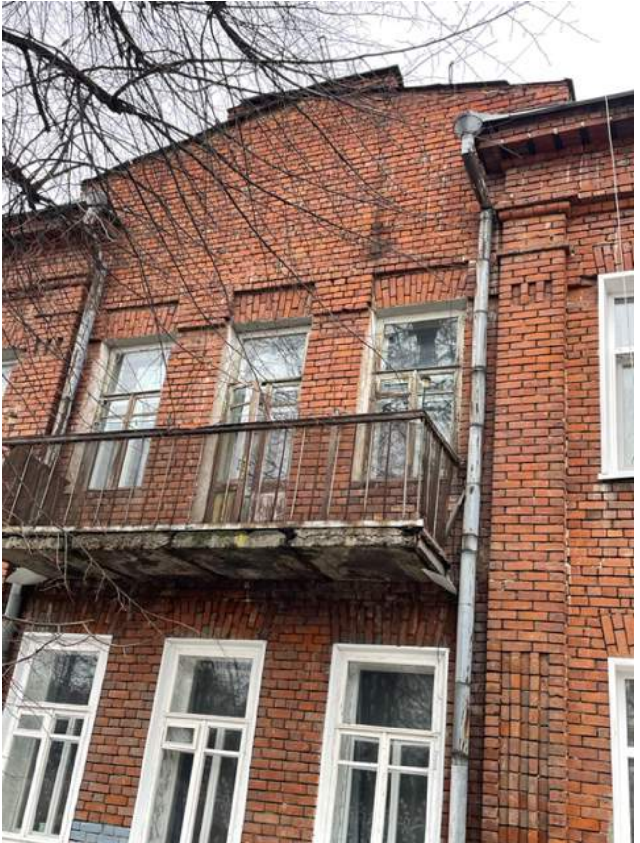
Фото 8. Центральная часть южного (главного) фасада. Эксперт Беляева Е. Э. 14.11.2023 г.
