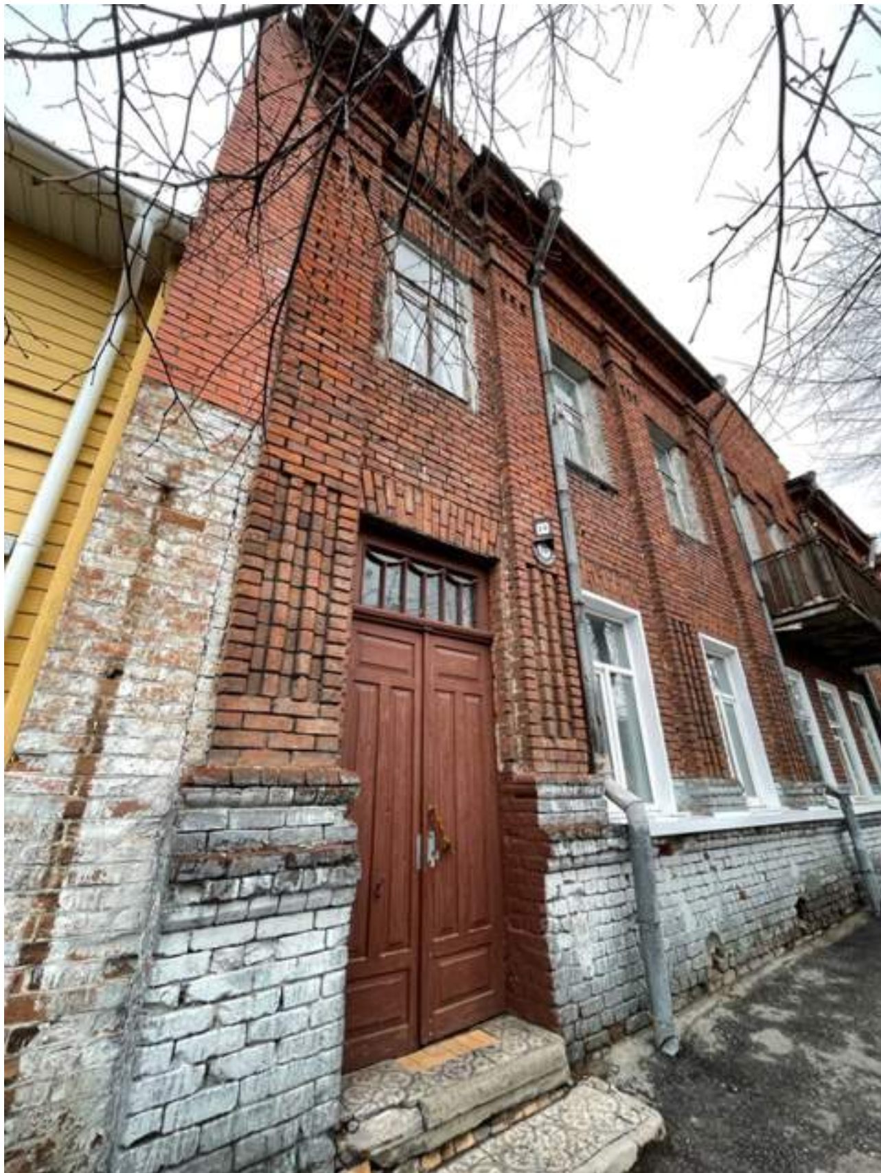
Фото 7. Фрагмент южного (главного) фасада. Эксперт Беяева Е. Э. 14.11.2023 г.
