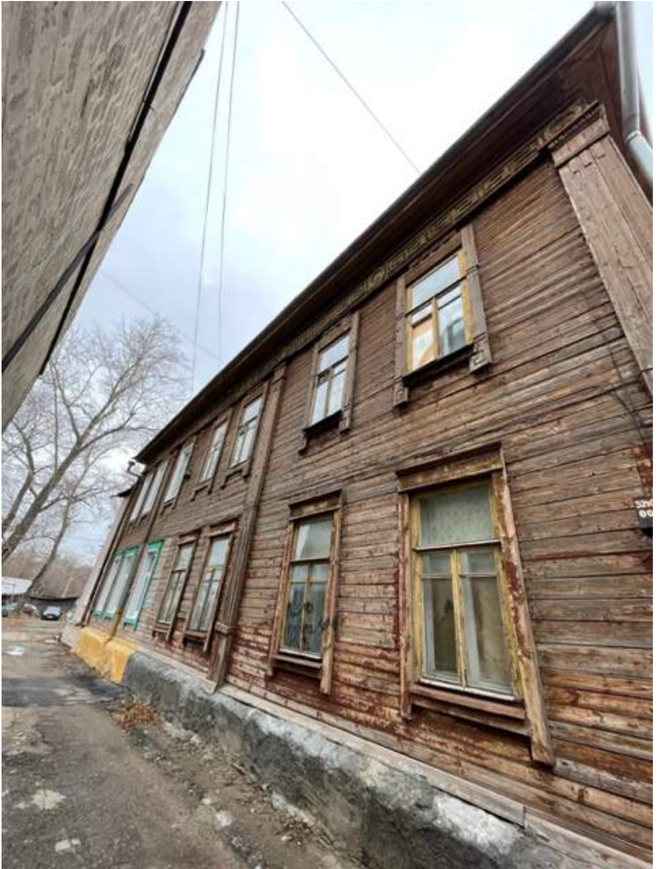
Фото 2. Западный фасад. Эксперт Беляева Е. Э. 14.11.2023 г.
